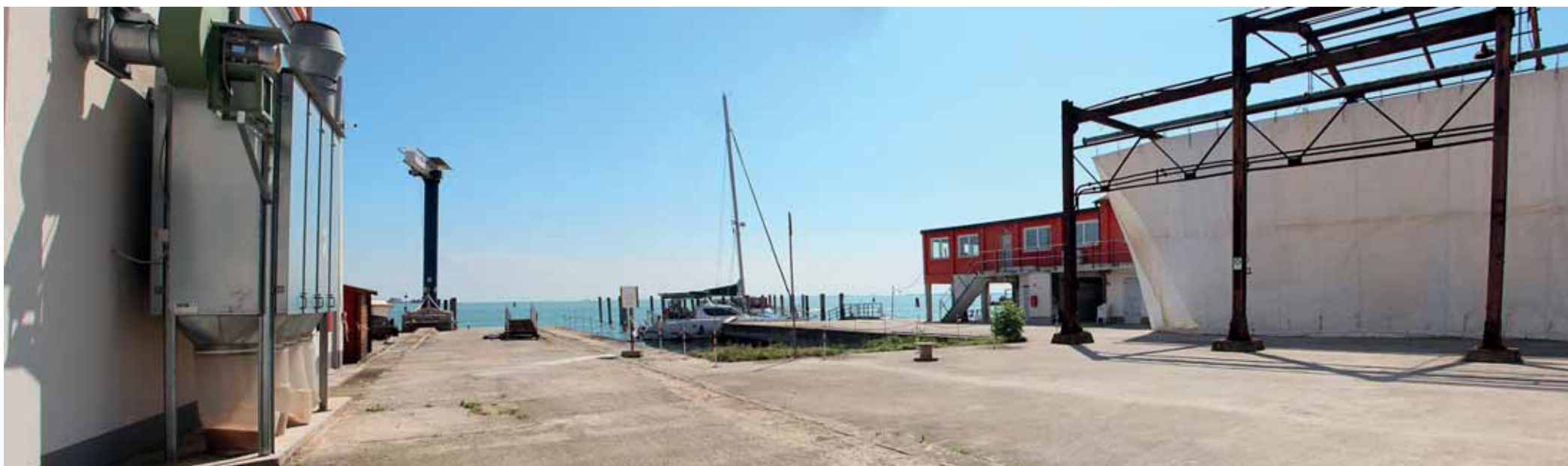
Maggio 2019 - Consorzio Venezia Sviluppo, riqualificazione banchina con relative infrastrutture.
