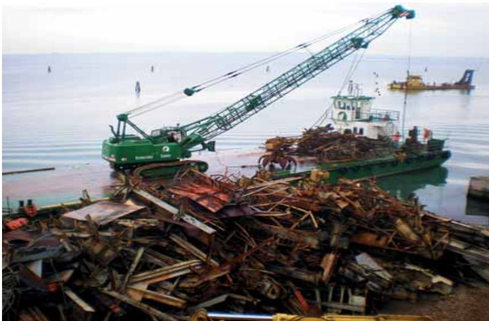
Aprile 2014, Rimozione delle gru portuali esistenti.
