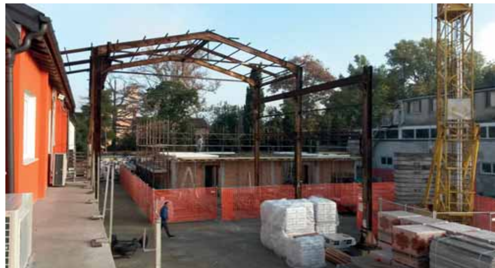
Novembre 2016 - Realizzazione edificio Pitteri Impianti S.r.l., 1° solaio.
