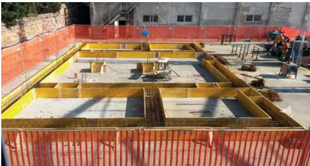
Ottobre 2016 - Realizzazione edificio Pitteri Impianti S.r.l., Le fondazioni.
