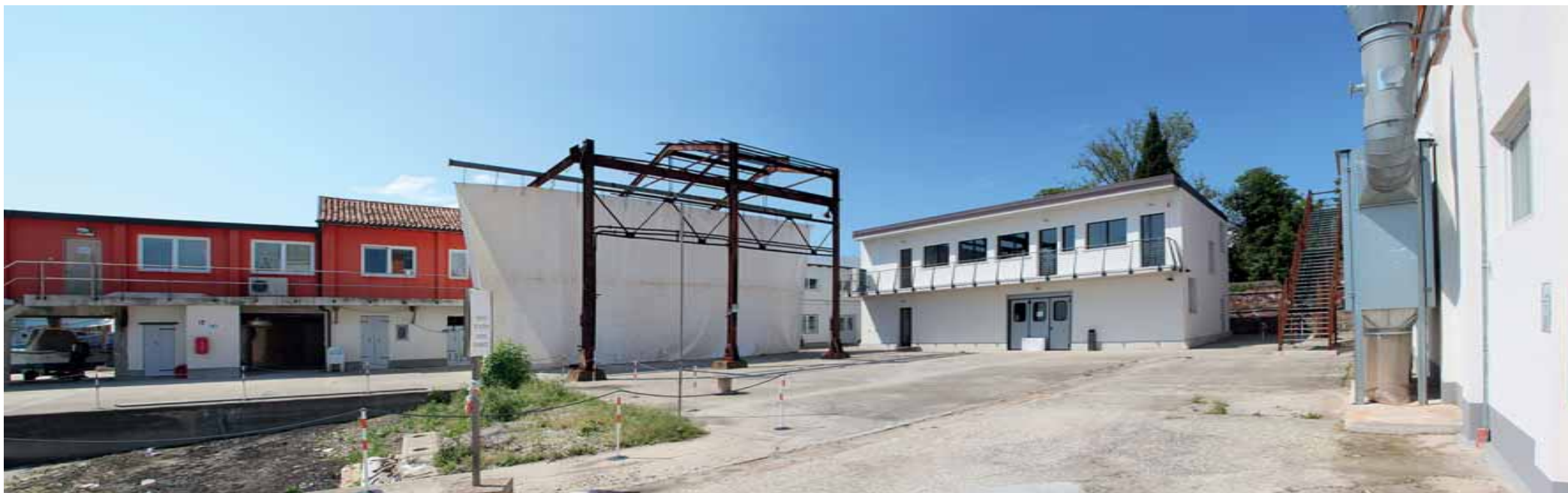
Maggio 2019 - Consorzio Venezia Sviluppo, riqualificazione banchina con relative infrastrutture.
