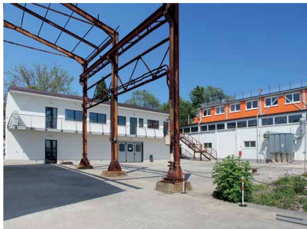
Maggio 2019 - completamento edificio Pitteri Impianti S.r.l.
