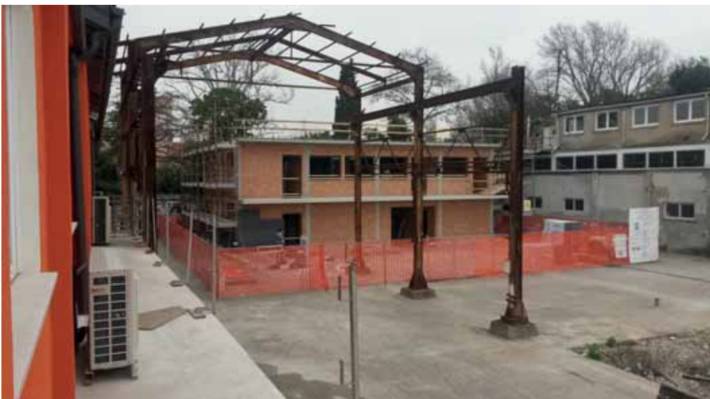
Marzo 2017 - Realizzazione edificio Pitteri Impianti S.r.l., struttura grezza.
